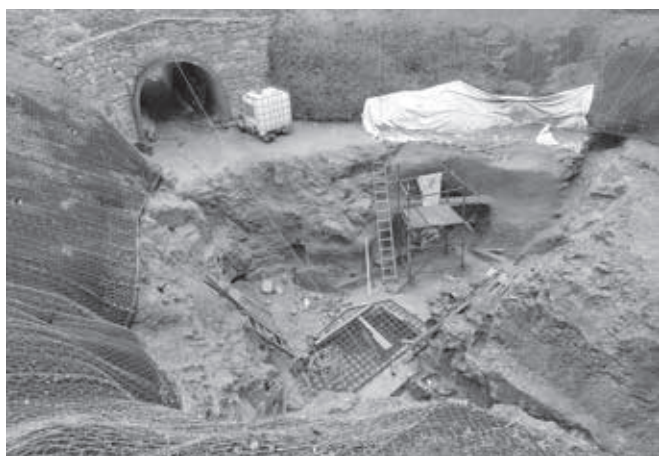
Zajištění opěrné zdi
