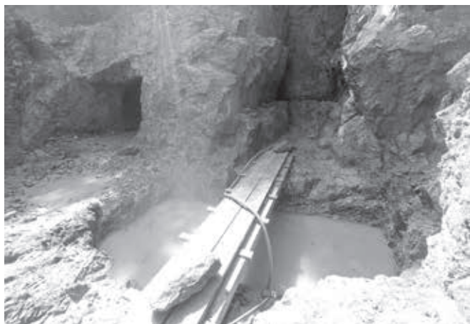
Zatopená ohlubeň šachty
