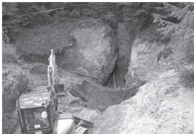
Odkrytí komory pohonného kola vodotěžného stroje
