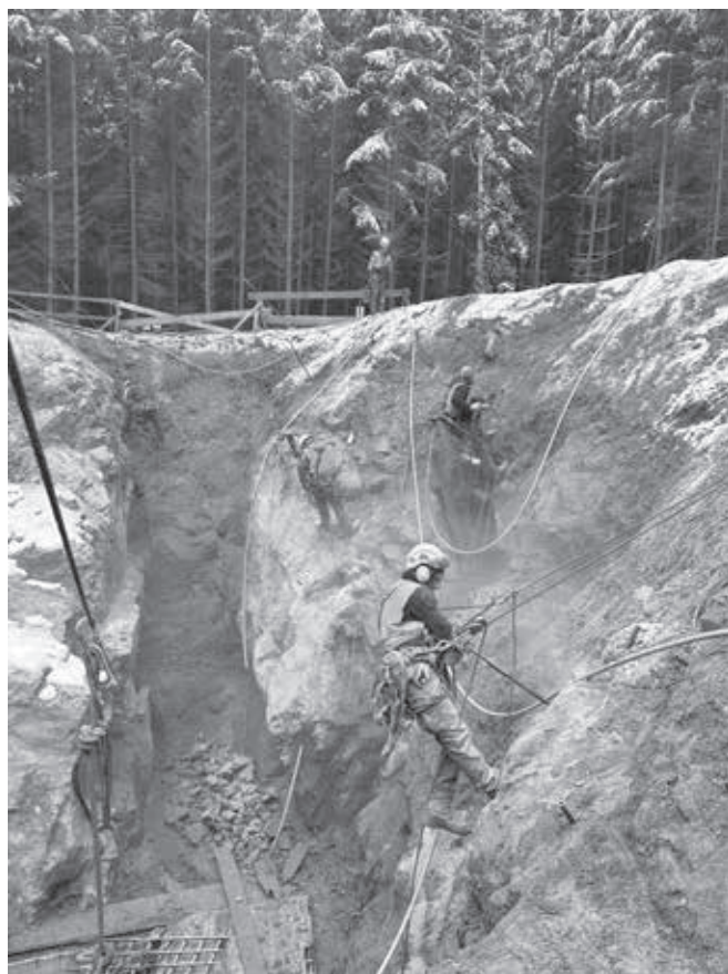
Kotvení nestabilních stěn
