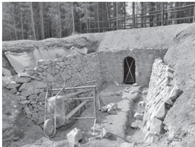
Stavba portálu odvodňovací štoly
